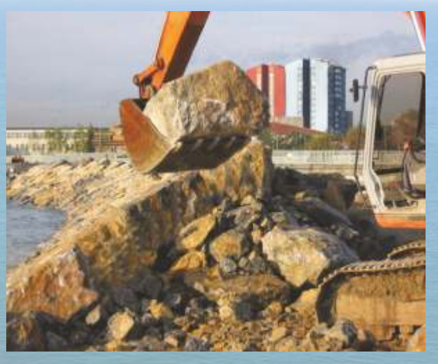
Zeytinburnu Ayvaldere Mendirek İnşaatı / 2008
